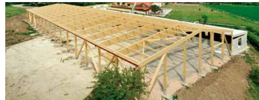
Reithalle Wagner, Kammern (AT) 242 m 3 Brettschichtholz Fichte, Satteldach Eindeckung: PU-Paneele
