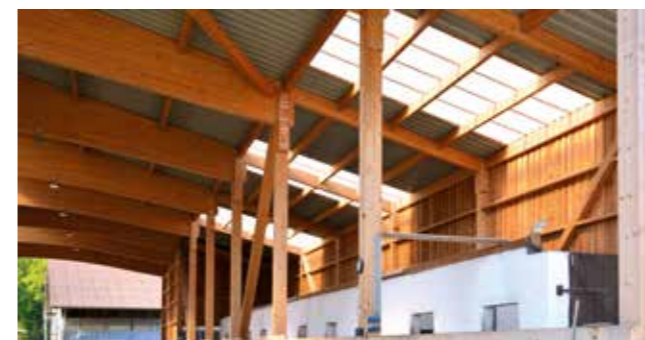
Reithalle Hofinger, Ranshofen (AT) 155 m³ Brettschichtholz Fichte, Satteldach Eindeckung: Tragschale
