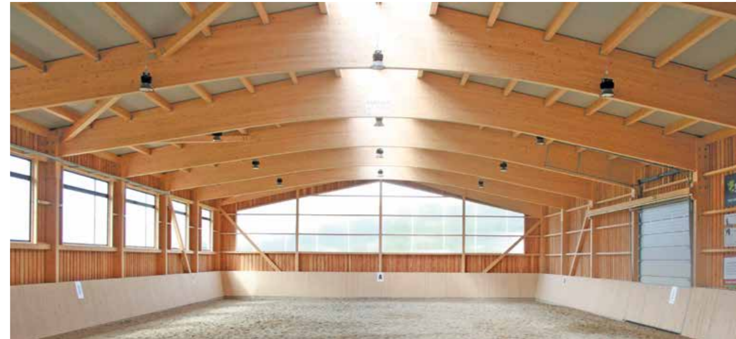
Reithalle Roscher, Ruden (AT) 166 m 3 Brettschichtholz Fichte, Satteldach Eindeckung: Elemente & PU-Paneele, Wandverkleidung: Elemente, Lärche
