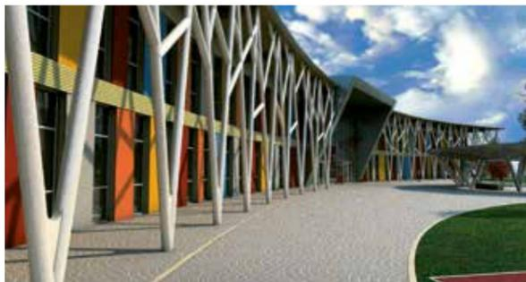
La struttura della nuova scuola elementare di Borgo Valsugana, con la sua facciata di grande impatto architettonico e ad elevata efficienza energetica, è realizzata interamente in legno. Per le pareti e i solai vengono utilizzati circa 1.310 m<sup>3</sup> di legno lamellare/X-Lam mentre circa 130 m<sup>3</sup> di legno lamellare sono previsti per la costruzione della copertura.
