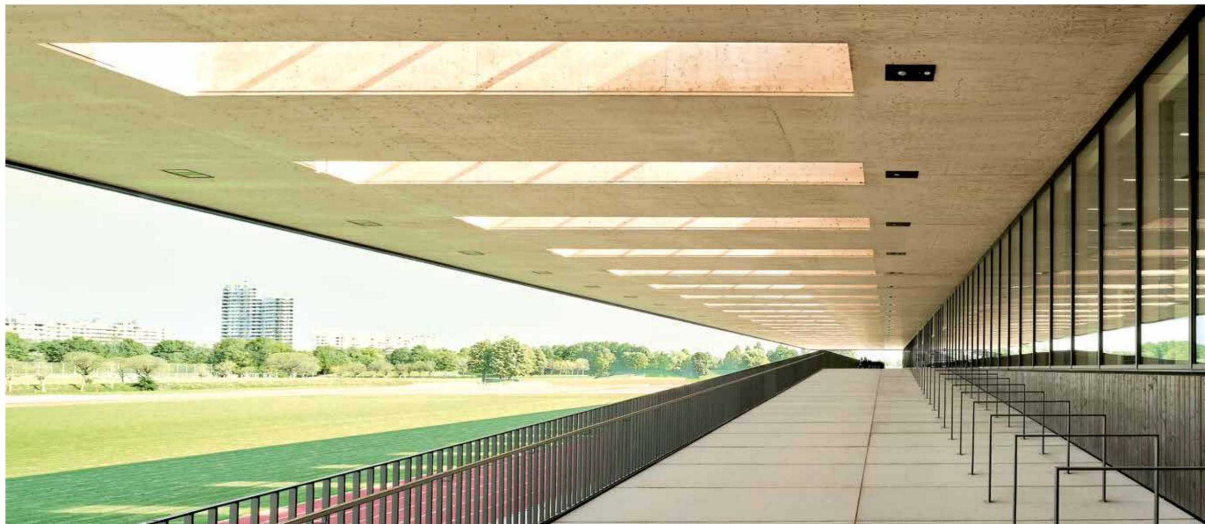
Il sistema portante di questa insolita costruzione è costituito da 40 elementi a sezione scatolare, ciascuno lungo 28 metri e del peso di 19 tonnellate.
