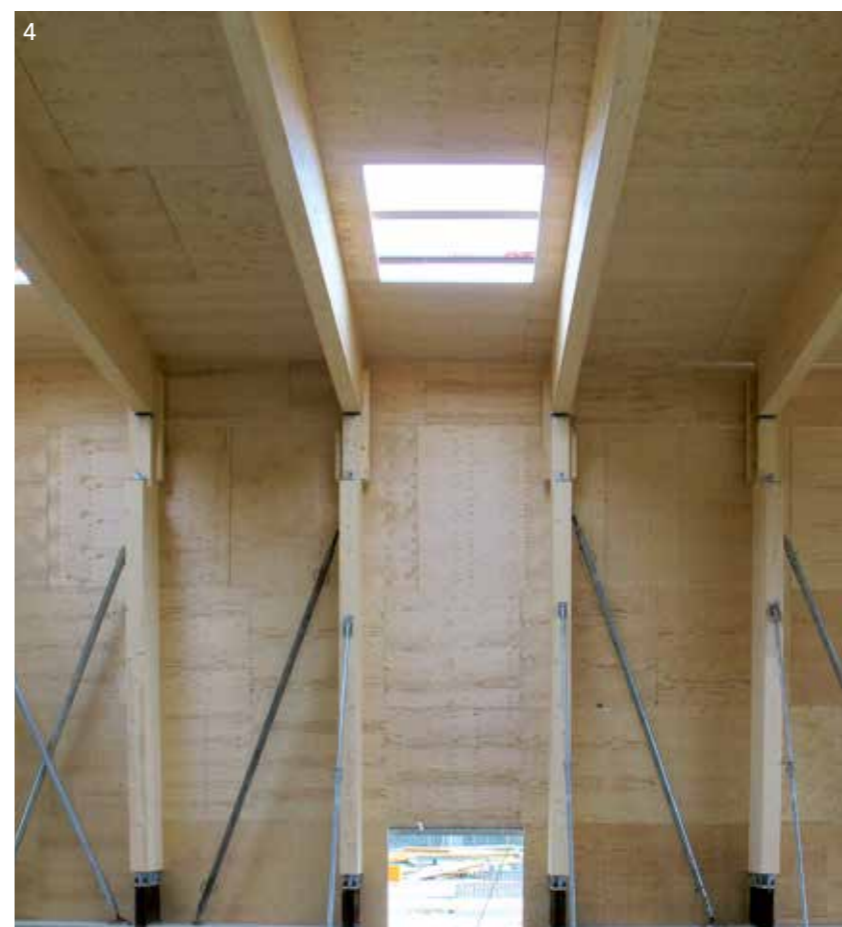
4. I sostegni del capannone sono già predisposti per l'installazione di eventuali rotaie per gru.
