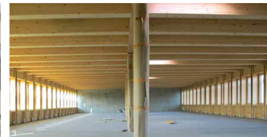
3. Con la loro massa, i solai compositi in legno-calcestruzzo minimizzano le oscillazioni nell'ala che ospita i laboratori.
